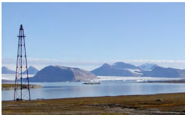
Fortøyningsmast for luftskip i Ny Ålesund.
